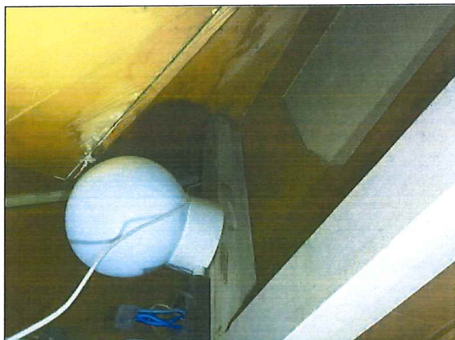
Foto 15: Trapkast: Plafondafwerking (Niet asbestverdacht)
