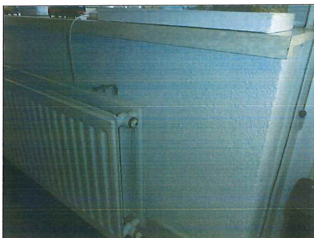
Foto 23: Woonkamer: Radiator (Niet asbestverdacht)
