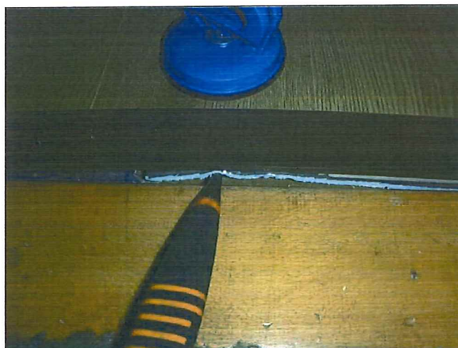
Foto 10: Slaapkamer: Onder vloerafwerking (Niet asbestverdacht)
