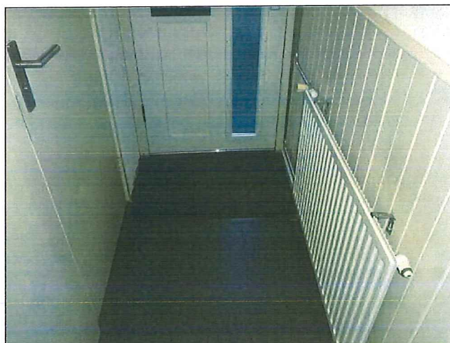
Foto 12: Hal: Radiator (Niet asbestverdacht)
