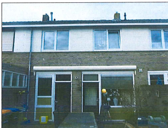
Foto 24: Achtergevel: Hemelwaterafvoer (Niet asbestverdacht)
