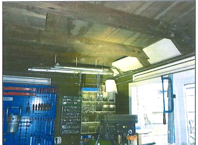
Foto 28: Berging: Binnenzijde (Niet asbestverdacht)
