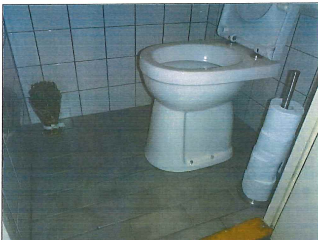
Foto 13: Toilet, vloer: Tegellijm (Ontoegankelijk)
