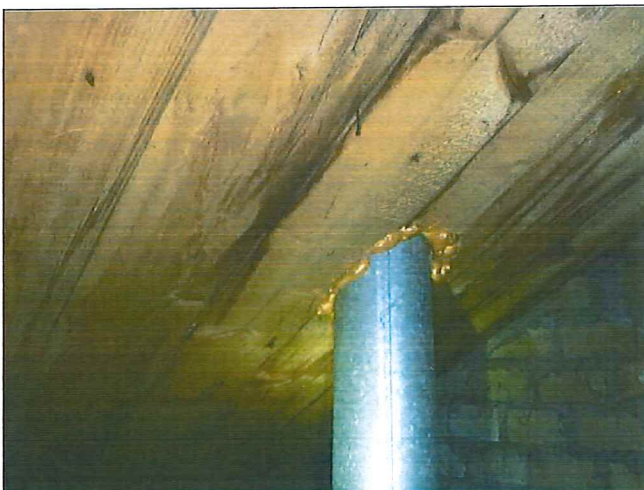
Foto 3: Zolder: Doorvoer (Niet asbestverdacht)
