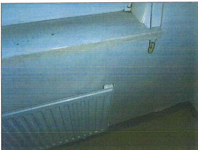
Foto 11: Slaapkamer: Vensterbank (Niet asbestverdacht)
