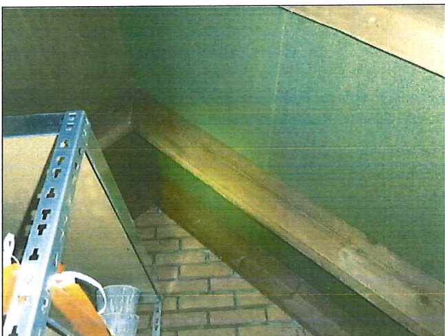
Foto 29: Berging: Dakbeschoot (Niet asbestverdacht)
