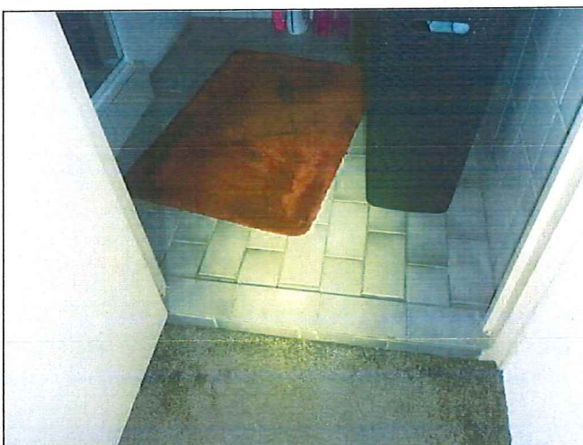
Foto 5: Badkamer, vloer: Tegellijm (Ontoegankelijk)
