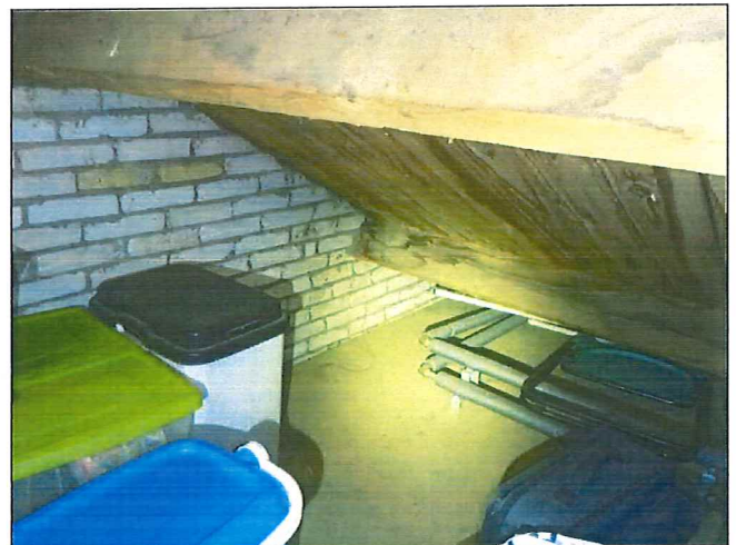
Foto 4: Zolder: Dakbeschoot (Niet asbestverdacht)
