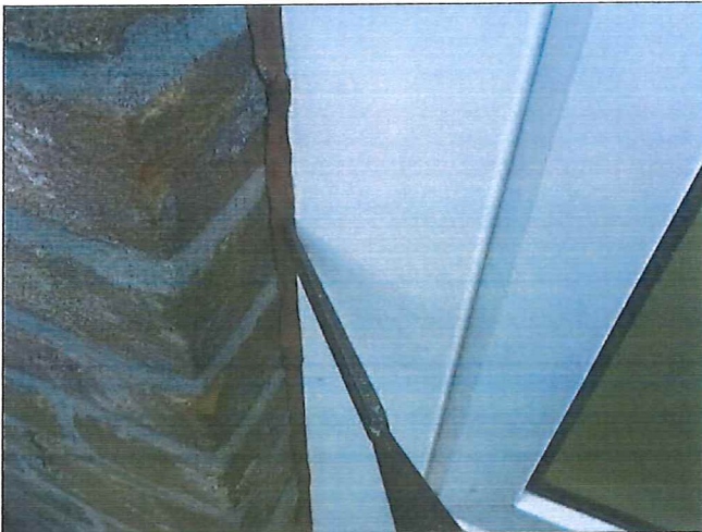
Foto 25: Achtergevel: Kit (Niet asbestverdacht)
