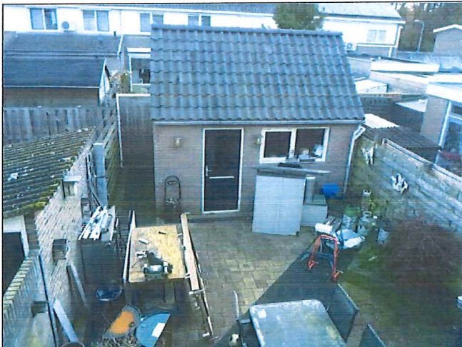
Foto 27: Berging: Buitenzijde (Niet asbestverdacht)
