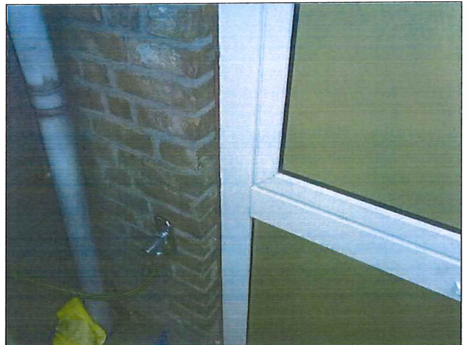
Foto 26: Achtergevel: Kozijnpanelen (Niet asbestverdacht)
