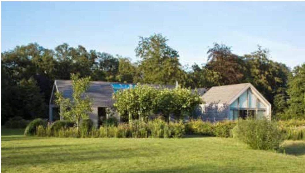
Afbeelding 70. Gebouw heeft vorm van schuur, ligt ingebed in landschap door gebruik landschapselementen
