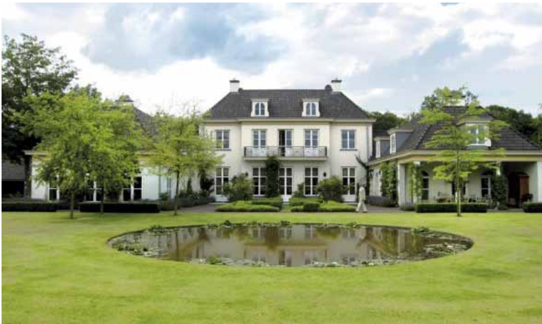
Afbeelding 58. Symmetrisch opgebouwde bebouwing en buitenruimte met zicht over waterpartij
