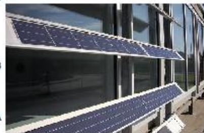
Voorbeeld van het toepassen van lamellen als PV elementen.
